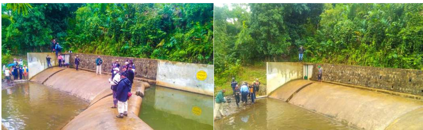
► 29 Juin 2021 : Inauguration des travaux d'aménagement du barrage de Sahanofia, Région Analanjirofo par le MAEP à travers le projet PADAP
